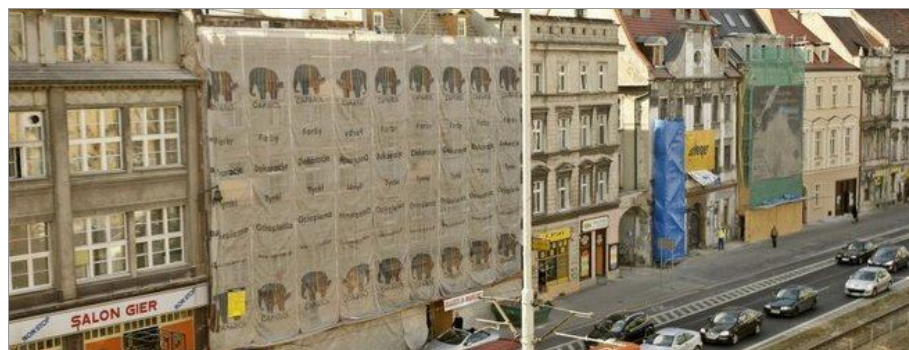
Trasa W-Z na odcinku od ul. Zamkowej do Świdnickiej to plac budowy. Będzie tu odnowionych większość kamienic (© Tomasz Hołod)
